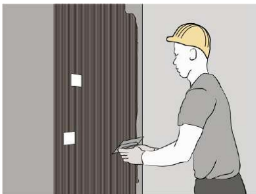
Нанесите клей на штукатурку / Spread adhesive on plaster
