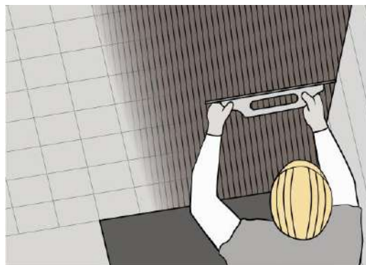
Нанесите клей на существующее основание / Spread adhesive on the existing substrate
