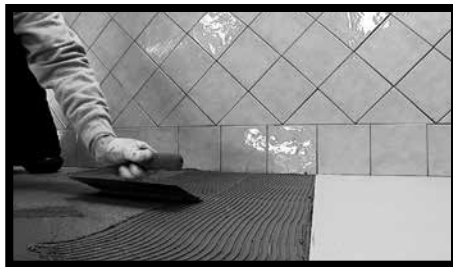
Рис. 62 - Укладка на пол
