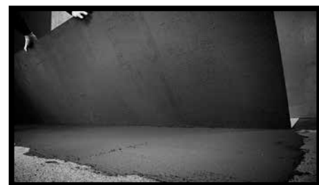
Рис. 68 - 2 - Должны укладываться, опирая одну из длинных сторон, затем опуская их на пол.
