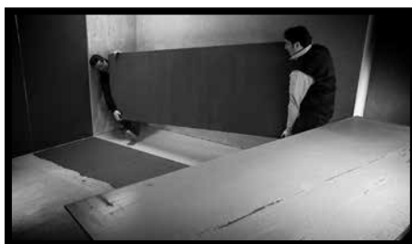
Рис. 67 - 1 - Плиты следует перемещать, поместив их сначала в вертикальное положение и удерживая за верхний край, затем переносить, удерживая их прямолинейно, вдвоем.
